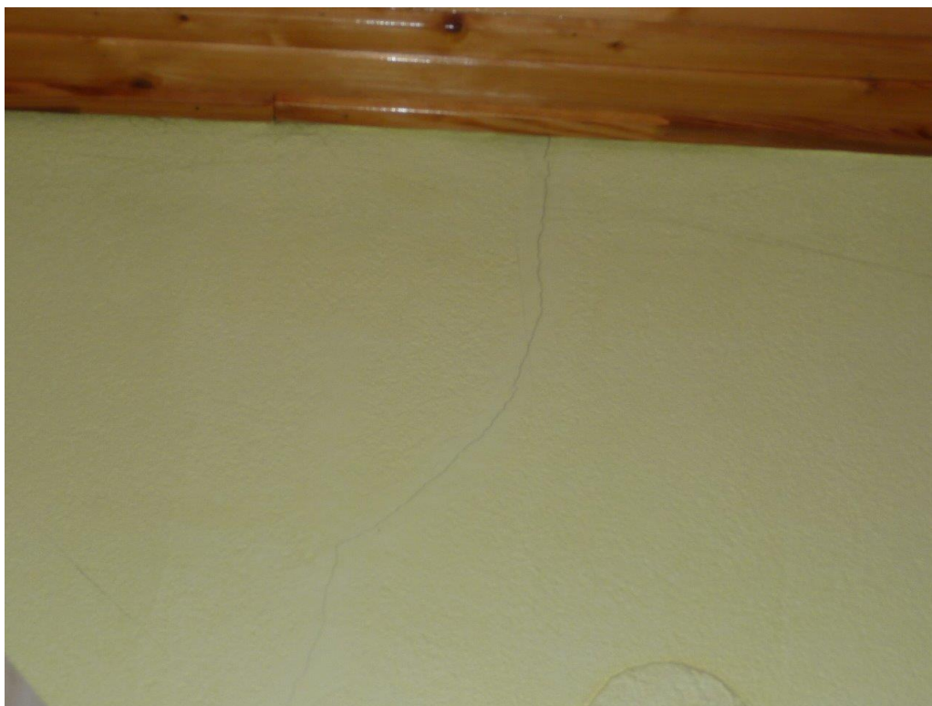
Foto č. 17 - Obývací pokoj v podkroví – trhlina u stropu
