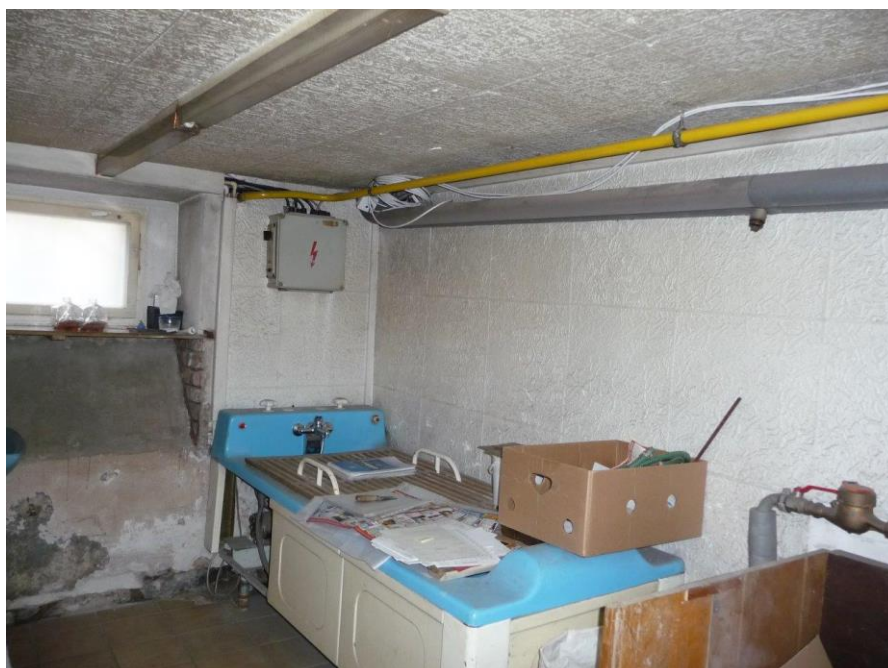
Foto č. 4 – Sklep – opadaná omítka pod sklepním oknem
