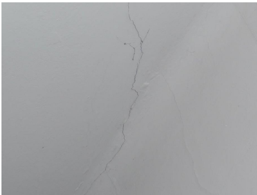
Foto č. 14 – Chodba k verandě – trhliny ve stropě a na stěně
