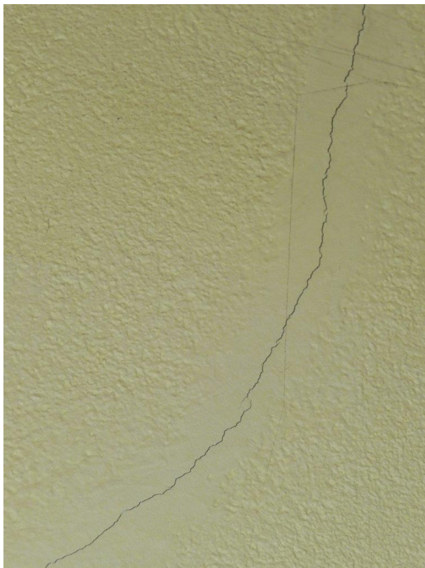
Foto č. 18 - Obývací pokoj v podkroví – trhlina u stropu - detail
